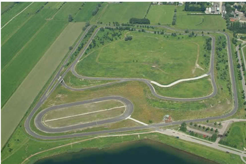
Accommodatie Nedereindseberg (Bron: Coöperatie Nedereindseberg)
